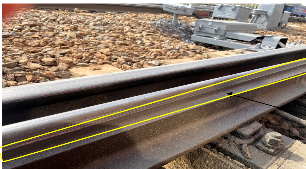
Рис.2. Наплыв металла по рабочей грани остряка (вид укрупненно)
