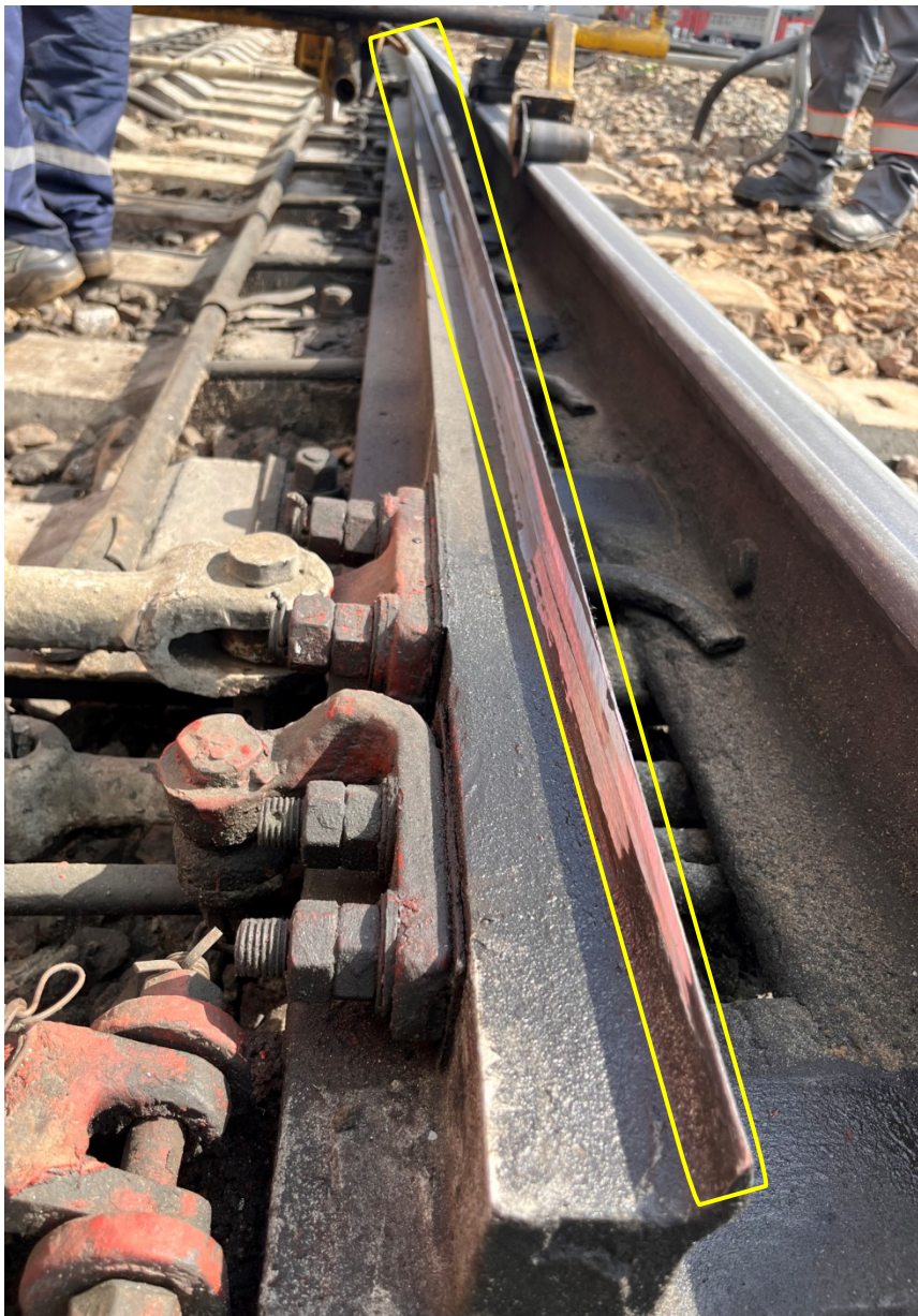
Рис.11. Шлифовка рабочей грани остряка
