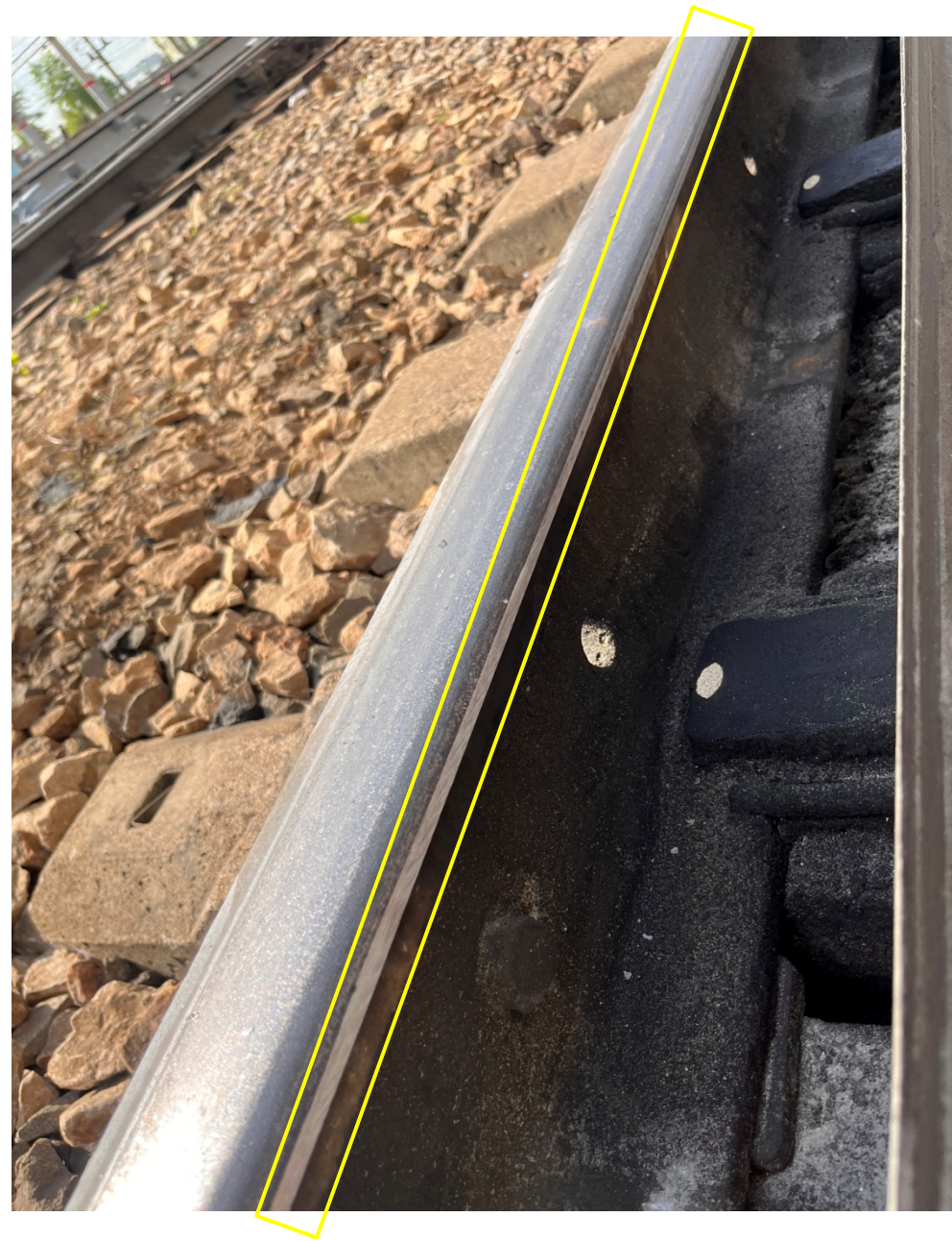
Рис.12. Шлифовка рабочей грани остряка
