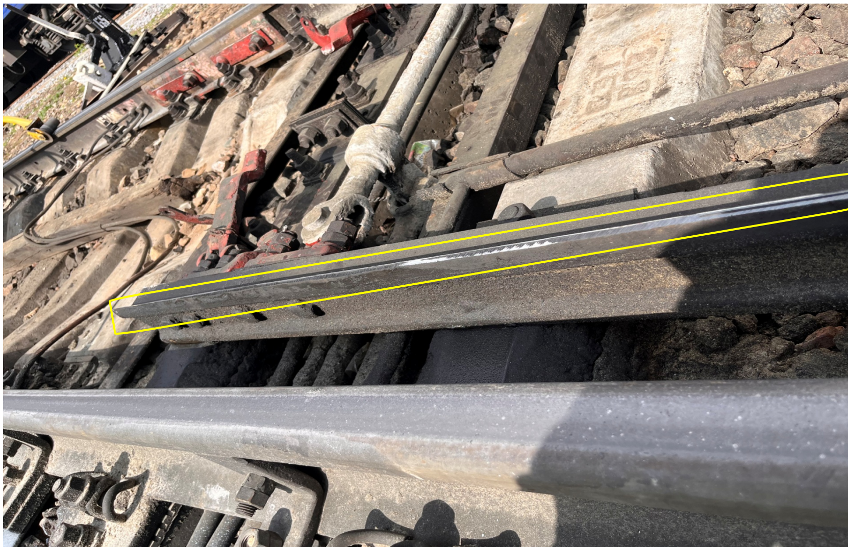
Рис.12. Шлифовка не рабочей грани остряка
