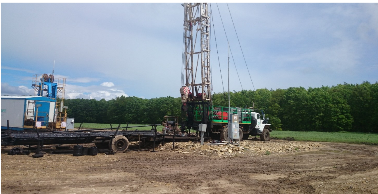
Рис.4 Оборудование бригады ТРС подготовленное к началу ремонта скважины
