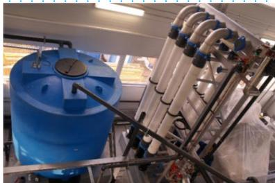
Контейнерная установка «под ключ» производительностью от 10 до 125 м<sup>3</sup>/сут для децентрализованной обработки сточных вод в удаленных местах, не имеющих доступа к системе общественной канализации
